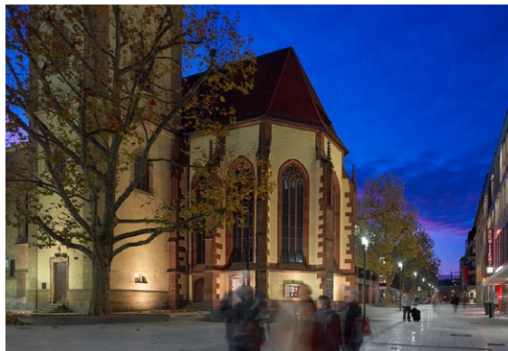
Abb. 54 Referenz - Beleuchtung Hospitalkirche Stuttgart
