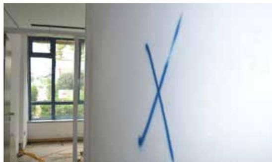
Die gesamte Elektrik, Fußbodenheizung und die Böden müssen an die neuen Räume angepasst werden. Markierungen an den Wänden verraten, welches Mauerwerk stehen bleiben darf und welches nicht.
